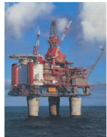
■ Fig. 1 - Exploatarea zăcămintelor off-shore - platformă petrolieră în Marea Nordului
